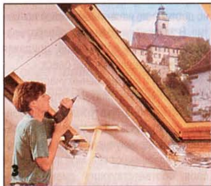
3 Листы обшивки крепят к обрешётке шурупами с помощью аккумуляторного винтовёрта со специальной насадкой. Самодельная подпорка удерживает лист гипсокартона и позволяет работать в одиночку.
