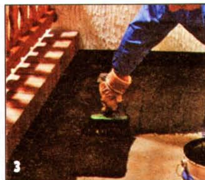
Толстый слой битумного каучука наносят поверх уплотнительной ленты.
