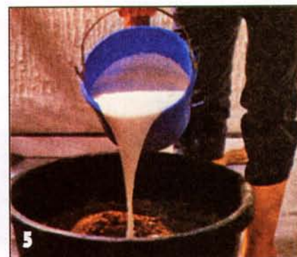
Раствор для стяжки затворяют водой с добавлением в неё синтетической эмульсии, повышающей стойкость стяжки к перепадам температуры.
