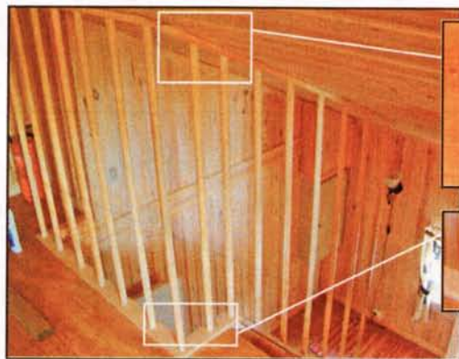
Сплошное ограждение лестничного проёма из круглых стоек, установленных с шагом 200–250 мм.
