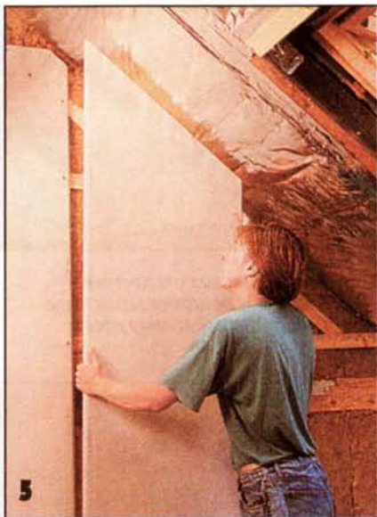
5 Фронтон также утепляют и обшивают гипсокартоном.
