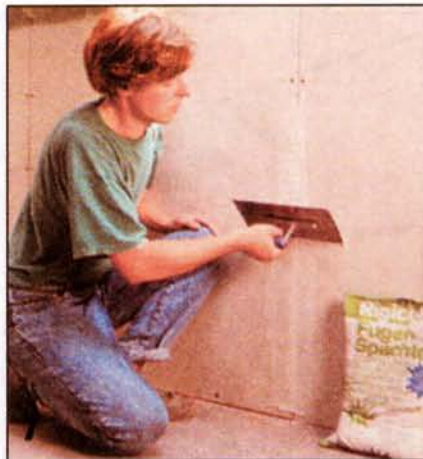
Швы между листами обшивки и лунки поверх головок шурупов тщательно шпательюют.
