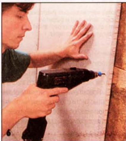
6 Работу ускоряет применение аккумуляторного винтовёрта.
