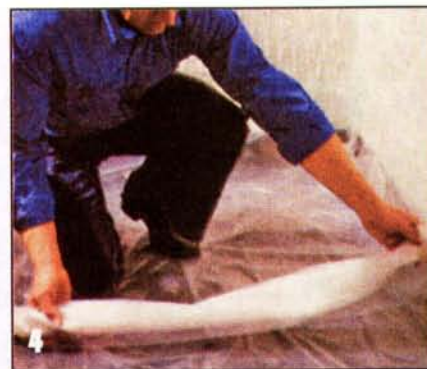
Чтобы покрытие было «плавающим», расстилают в два слоя полиэтиленовую плёнку.
