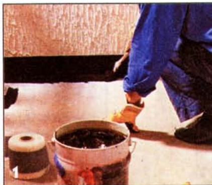
При уплотнении пола на балконе сначала битумный каучук обильно наносят в зоне между полом и стеной.
