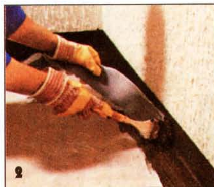
В нанесённый слой битумного каучука закладывают уплотнительную ленту.
