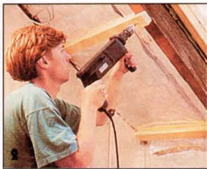
2 Утепив скаты крыши, крепят бруски обрешётки под обшивку гипсокартоном.
