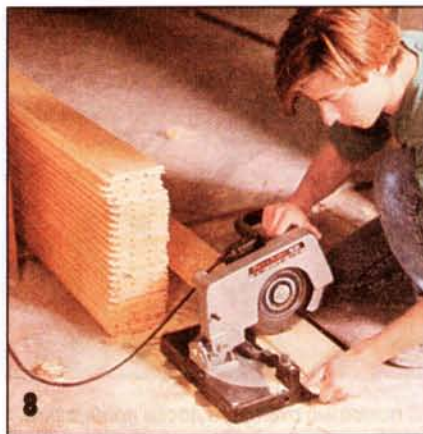
8 Шпунтованные доски для обшивки потолка и наклонных участков стен раскраивают по длине.
