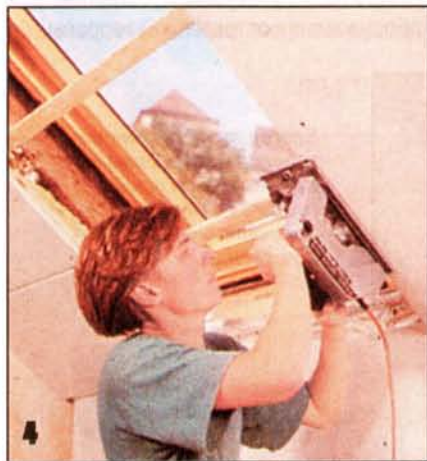
4 Выступающие из под обшивки бруски обрешётки в зоне окон обрезают заподлицо с краями гипсокартонных листов.
