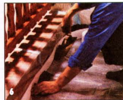
У стены кладут пенополиуретановые полосы, закрепляя их точно раствором.
